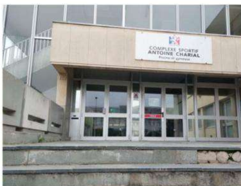
Le complexe sportif Charial, actuellement fermé, en attente des travaux. Photo Christian Salisson
