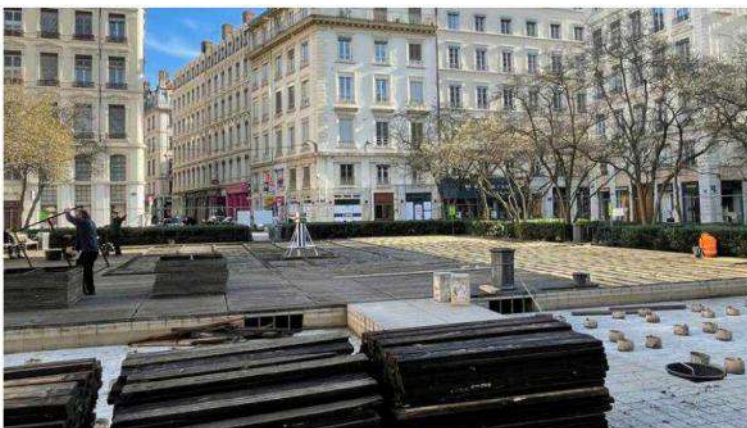
Démontage à gauche et début du platelage à droite. Photo Michel Nielly
