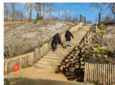
L'escalier flambant neuf offre une connexion supplémentaire entre la partie basse et la partie haute du parc. Photo Rémi Liogier
