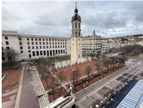
Travaux place Antonin Poncet, pour l'installation d'un nouvel éclairage public. ©Veronique Lopes
