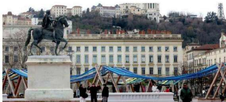
Le chantier a démarré en octobre 2025. L'objectif était de restaurer l'esplanade autour de la statue à l'identique. Photo Richard Mouillaud
