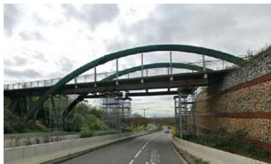
La passerelle Porte des Alpes va être détruite à Saint-Priest. Google Maps
