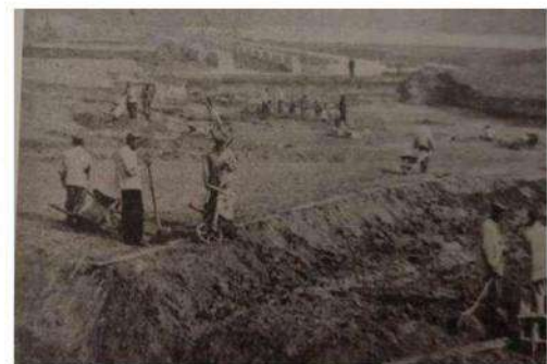
Construction du stade de Gerland par des prisonniers allemands en 1915 Photo archives municipales de Lyon
