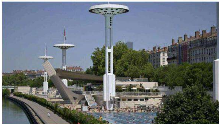
En bordure du Rhône à Lyon, le centre nautique Tony-Bertrand est très attractif. Mais sous ses plages en dur, les défauts techniques vont imposer une longue fermeture. Photo Maxime Jegat
