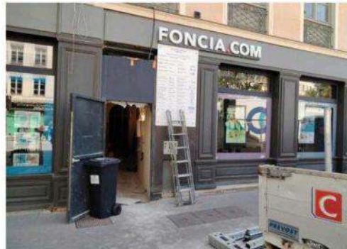
Un incendie s'était déclaré en avril 2019 dans l'immeuble situé au 22 place de la Croix-Rousse. Depuis sept ans, le bâtiment restait inoccupé. Photo Yves Le Flem
