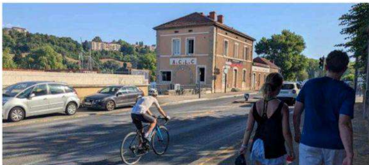
En surélévation du hangar à bateaux, une salle de sport de 431 m 2 est en cours de construction. La rénovation du bâtiment principal suivra. Photo Sylvie Silvestre
