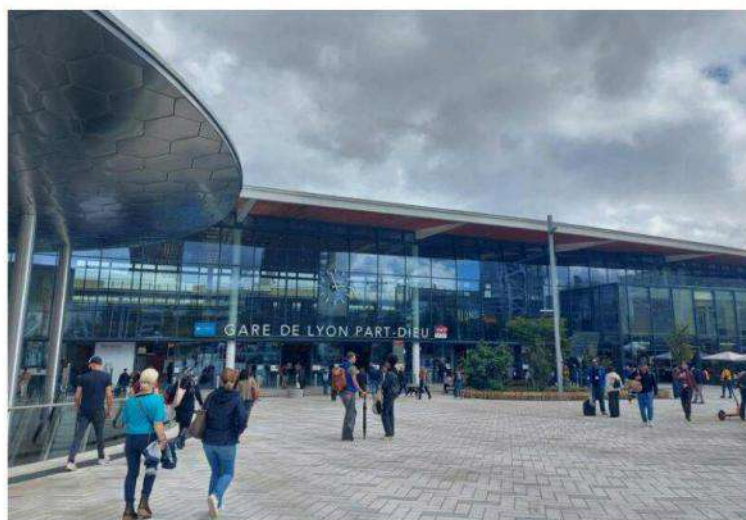
Lors de l'inauguration de la nouvelle place Béraudier, le 22 septembre. Photo Pauline Cavallier
