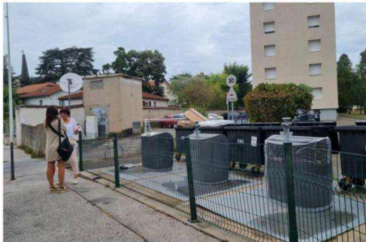
Rue des Aqueducs, dans le quartier Point du Jour, les silos installés proches du trottoir pour la résidence d'Alliad Habitat sont « hors service » depuis le début de l'année. Photo Christelle Lalanne
