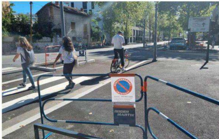
La Voie lyonnaise 8 est déjà accessible avenue Mermoz mais la livraison définitive du chantier sur ce tronçon est prévue mi-octobre. Photo Régis Barnes
