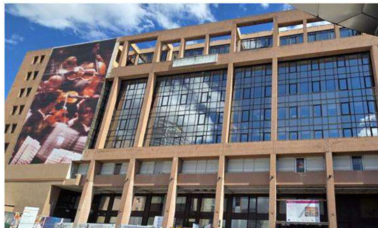
Le permis de démolir qui vient d'être affiché, concrétise la disparition du « dernier bâtiment de l'ancienne gare de la Part-Dieu », le « B4 » livré en 1983. Photo Aline Duret
