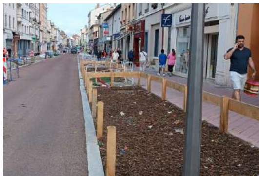
Les travaux de l'avenue des Frères-Lumière, jeudi 21 août. © DR
