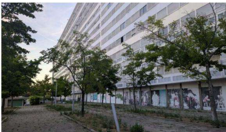
La déconstruction du "Château" de la Duchère va avoir lieu pendant deux ans et demi. Photo Marie-Agnès Laffougère
