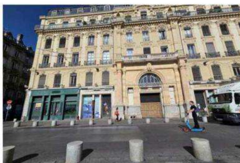
Ancienne galerie marchande qui relie la place de l'hôtel de ville à la rue Lanterne, la Galerie des Terreaux, fermée depuis une trentaine d'années, doit être rénovée. Les travaux ont démarré, aujourd'hui ils sont à l'arrêt. Photo Aline Duret
