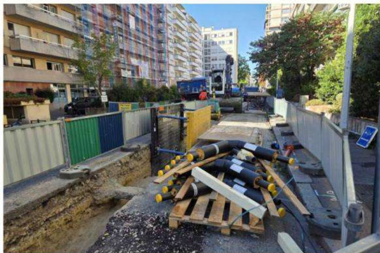
La rue Sully est en travaux et barrée, du boulevard des Belges jusqu'à la rue Garibaldi.
