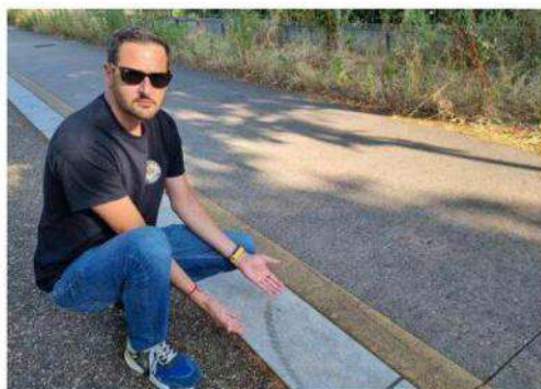
La bordure n'est pas à niveau, l'un des côtés est légèrement plus haut que l'autre, explique Maxime Rinck. Photo Aline Duret
