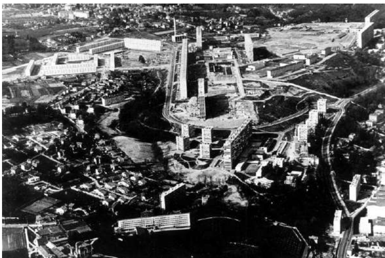
La Duchère prend forme, le fort a disparu, les constructions se poursuivent par les équipements publics et les centres sociaux © DR
