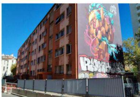
Les travaux de l'immeuble situé au 2 rue Jacquard s'échelonneront jusqu'en 2030. Photo Yves Le Flem
