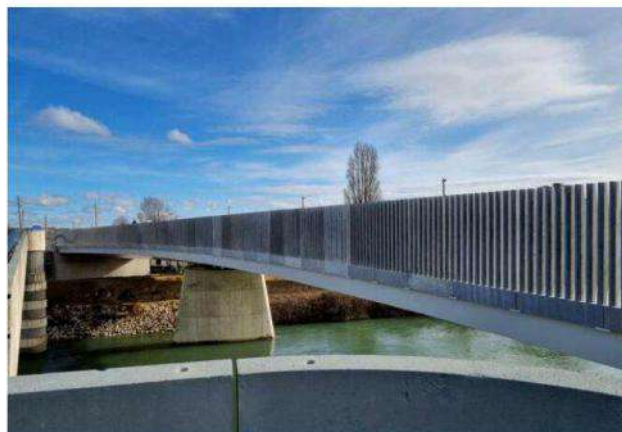
Le pont de Saint-Jean s'appuie sur deux appuis terrestres et deux piles nautiques dans le canal de Jonage. Photo Vincent Sartorio
