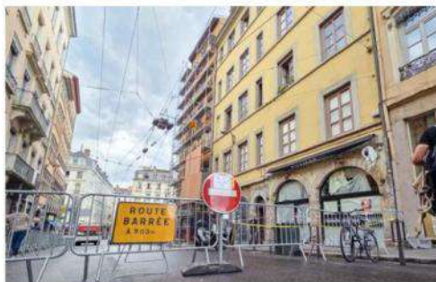
Deux immeubles menacent de s'effondrer rue Terme, à Lyon (1 er ). Photo Joël Philippon
