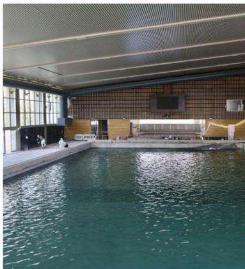
De gros travaux de rénovation avaient déjà entraîné la fermeture de l'équipement pendant plus d'un an.
