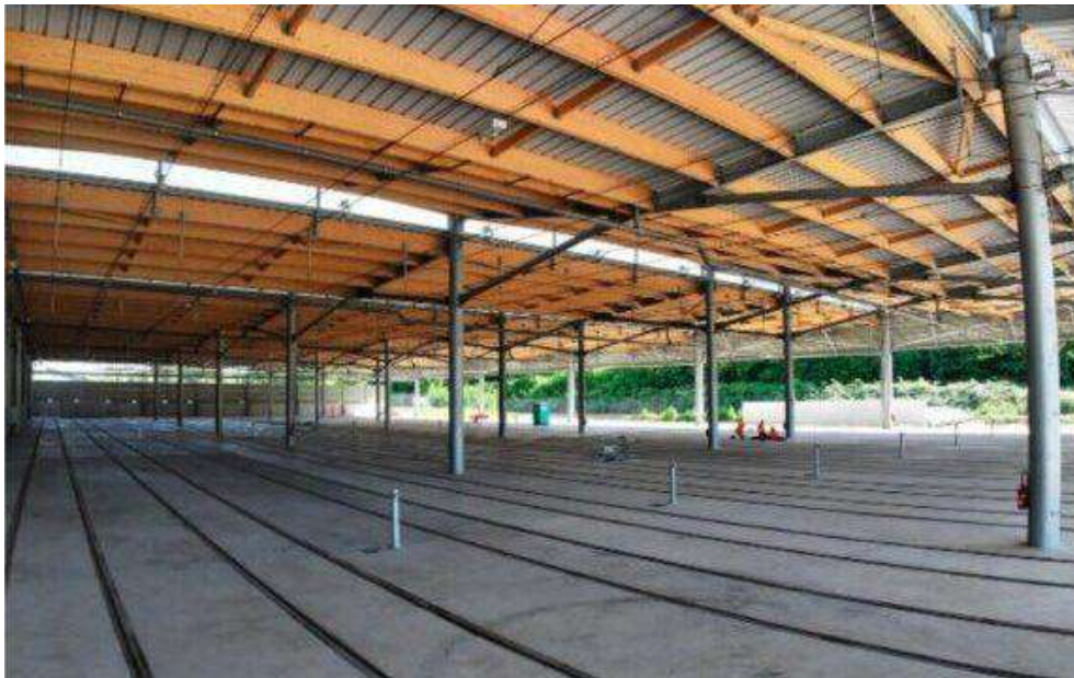
Centre de maintenance des tramways à Saint-Fons. Crédit : Sytral Mobilités
