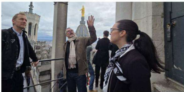
État des lieux sur les toits de Fourvière en présence d'Antoine Requin (Fondation Fourvière), Philippe Allart et Amandine Mouraud tous deux architectes (agence Alep). Photo Aline Duret
