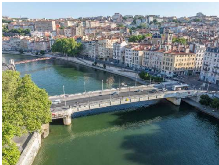
Pont de la Feuillée à Lyon. (@Métropole de Lyon)
