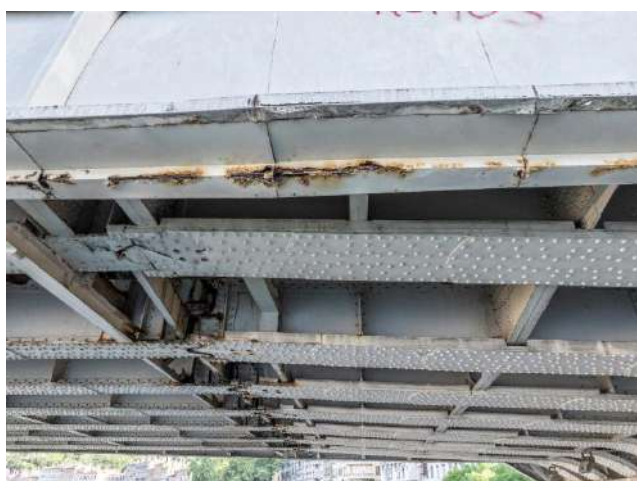
Pont de la Feuillée à Lyon : corrosion de certaines parties de la charpente métallique. (@Métropole de Lyon)
