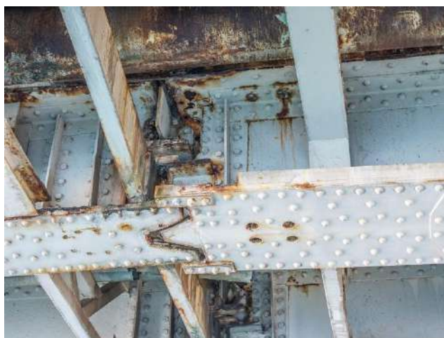
Pont de la Feuillée à Lyon : corrosion de certaines parties de la charpente métallique. (@Métropole de Lyon)
