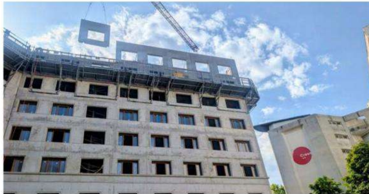
Cet été, le 7 e et dernier étage de la résidence a été posé. Une partie des étages a été préfabriquée avec du béton de bois. Photo Anne-Laure Wynar
