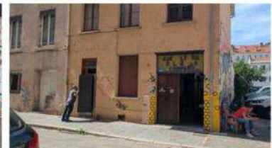
Au 24 rue Cluzan, des portes anti-squats sont installées dès le rendu des clés avant une démolition prochaine. Photo M-A Laffougère
