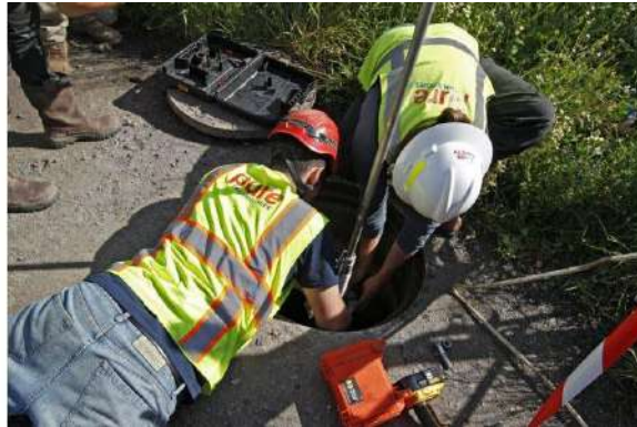
Des techniciens cherchent une fuite sur le réseau à l'aide d'un capteur acoustique. Photo d'illustration Sipa /M.Libert
