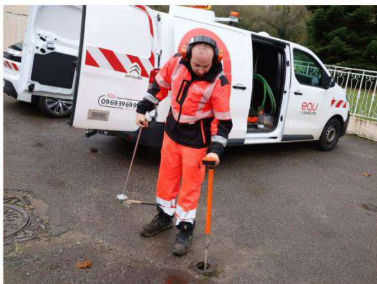
Plus de 4 000 kilomètres de canalisations sont nécessaires pour distribuer l'eau potable aux habitants de la Métropole. Photo archives Richard Mouillaud
