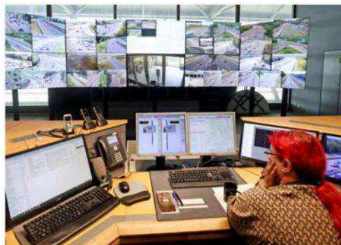
Depuis le PC de Genas, sept opérateurs se relaient 24h/24 pour surveiller le réseau, analyser les incidents et piloter les panneaux à messages variables. Photo Richard Mouillaud
