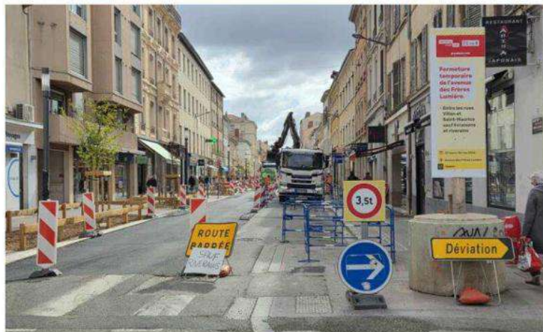
Une déviation est mise en place à l'angle de la rue Villon et de l'avenue des Frères-Lumière interdite aux voitures jusqu'à la rue Saint-Maurice. Photo Régis Barnes
